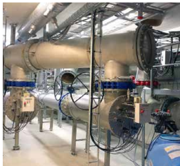
Zwei Spektron 650e-UV-Desinfektionssysteme
